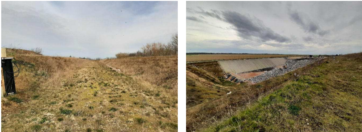
Figure 25 : Photo graphie de visite du site en 2022 de la zone du casier amiante lié (à gauche) et de l'extension de 2016 (à droite) (Source : Antea Group)
